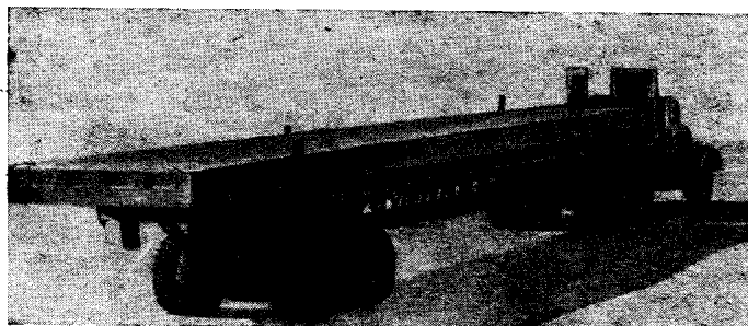
Рис. 1. Общий вид кровельной плиты размером 3x18 м
