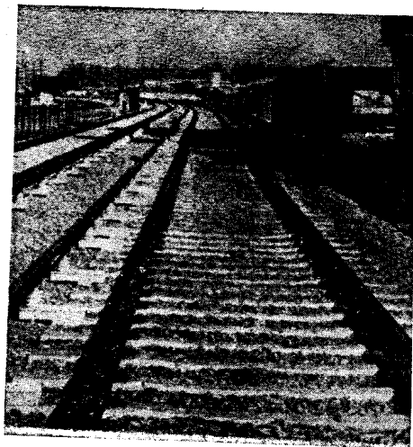
↑ Рис. 7. Преднапряженные железобетонные шпалы на линии метро
